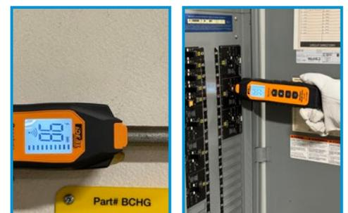
Ajustez la sensibilité si nécessaire pour optimiser l'intensité du signal reçu. Il est important de bien orienter le récepteur. Cela peut nécessiter un ajustement pour maximiser l'intensité du signal affiché.
