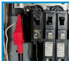
Attachez les pinces crocodiles au fil neutre et au fil de terre du disjoncteur.
