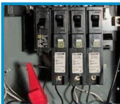
Attachez les pinces crocodiles à la barre de neutre/terre et au fil de phase du disjoncteur.
