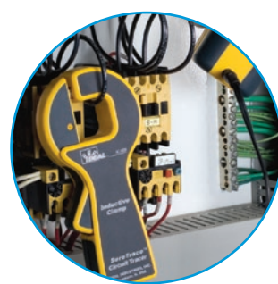
Pince inductive pour les cas où le contact direct avec les pinces crocodiles n'est pas possible
